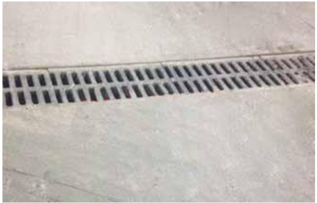
SONG CHẮN RÁC GANG XÁM KT 960×530 TẢI TRỌNG 1,5T Model: SCRX: 9653 / Tiêu chuẩn: EN124
